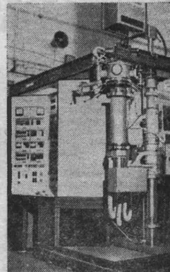
НА СНИМКЕ: автоматическая плазменная установка «Монокристалл-ПД-4», созданная в СКБ для выращивания монокристаллов тугоплавких металлов, сплавов и соединений, с использованием исходных материалов в порошкообразной форме.
